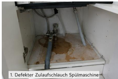
1. Defekter Zulaufschlauch Spülmaschine
